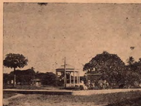
El Parqucito de Filadelfia cuyos trabajos quedaron paralizados
